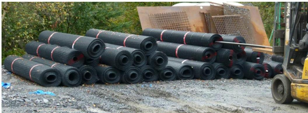
Figure 2 - Entreposage de la géogrille
