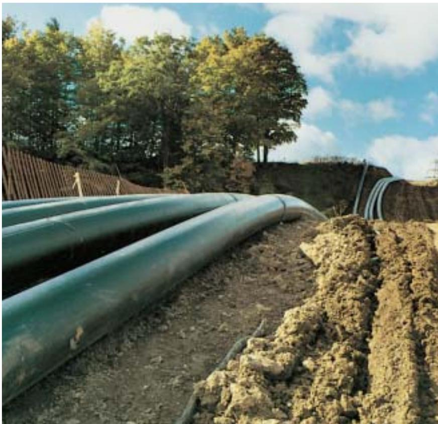
Le SCLAIRPIPE est offert dans un éventail de plus de 10 cotes de pression décrites en rapport dimensionnel (DR). Le rapport dimensionnel est tiré du rapport entre l'épaisseur minimale de la paroi du tuyau et le diamètre extérieur tel qu'indiqué plus loin sous la rubrique « spécifications générales ». La pression d'opération du tuyau dépend du rapport dimensionnel et est basée sur une alimentation d'eau à 73°F pour une vie minimale de 50 ans.
