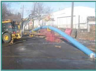
**I**PEX a mis au point les nouveaux tuyaux en PVC Brute Fusionnée<sup>MC</sup> et Série Fusionnée<sup>MC</sup>. En mettant
