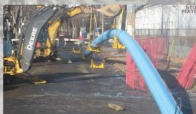
Le tuyau Brute Fusionnée DR25 a été choisi car il offrait des caractéristiques de débit optimales pour le gainage d'une conduite d'acier
